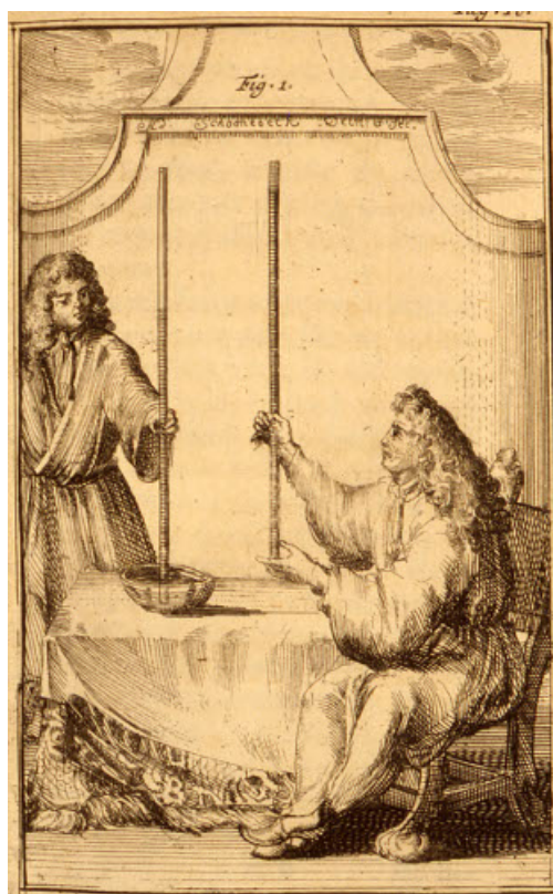
Figure 3. Torricelli et l'expérience du vide en 1643 [ Source : © D'ALENCE J. (1688) Traité des baromètres, thermomètres et notiomètres , Amsterdam].
