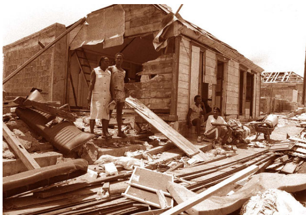
Figure 10. Dégâts causés par le passage sur la Guadeloupe du puissant cyclone Hugo le 17 septembre 1989 [ d'après http://www.guadeloupe.franceantilles.fr/actualite/education-sante-environnement/dossier-cyclone-en-guadeloupe/ ]
