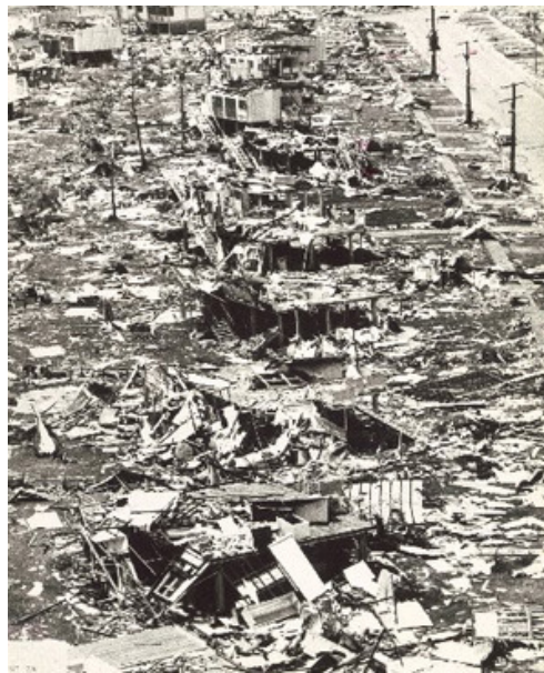
Figure 4. La ville de Darwin, au nord de l'Australie, dévastée par le passage du cyclone Tracy à Noël 1974 [ source : https://s.yimg.com/ea/img/-/140824/cyclone_tracy_19vivve-19vivvs.jpg ]
