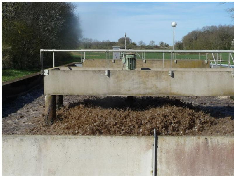
Figure 6. Bassin de boues activées aéré à l'aide d'un agitateur mécanique. [Source : © Joseph De Laat]
