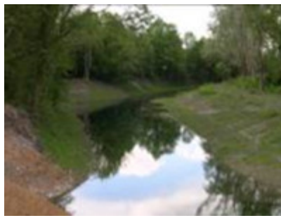
Figure 10. « Lône » de Malourdie (Chute de Chautagne) after restoration work [Source: © Camille Moirenc]
