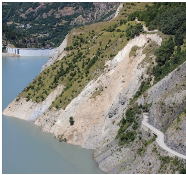
Figure 1. Glissement de terrain du Chambon [Source : SAGE, https://www.sage-ingenierie.com/glisement-de-terrain-du-chambon/ ]
