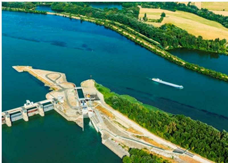
Figure 8. PCH et passes à poissons à Rochemaure – Mise en service 10/2015 [Source : ©Camille Moirenc]
