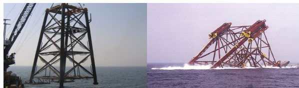
Figure 2. A gauche, un des éléments de jackets support d'une plateforme off-shore, jusqu'à 300 m d'eau, taille et poids comparable à ceux de la Tour Eiffel. A droite, jacket muni de caissons de flottaison, en cours de remorquage sur site ; fourreaux de guidage des pieux (diamètre 2 m, longueur 50 à 100 m) de clouage sur le fond marin sableux. [source : A. Puech, 2008, Cours de géotechnique marine, ENSHMG ]
