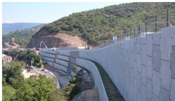
Figure 6. Un mur de soutènement de grande hauteur en « terre armée ». Chaque niveau de mur est constitué d'« écailles » jointives en béton armé ancrées par frottement dans le remblai amont grâce à des tiges métalliques. Le remblai est construit au fur et à mesure de l'érection du mur. Cette technique permet de réaliser des parois esthétiques, sub-verticales stables, et drainantes. [source : E. Lucas, P. Sery, A. Tigoulet, D. Brancaz, 2008, Les ouvrages récents de grande hauteur en sol renforcé, Compte rendus JNGG 2008, Nantes]
