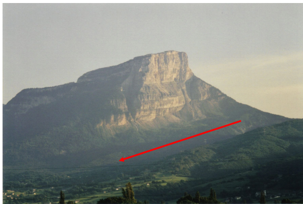
Figure 3. Glissement du Granier [Source : photo D. Hantz].
