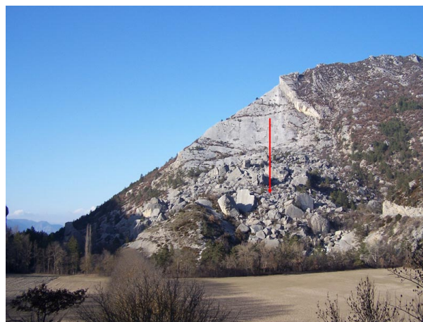
Figure 2. Glissement du Claps de Luc [Source : photo Didier Mazet-Brachet].
