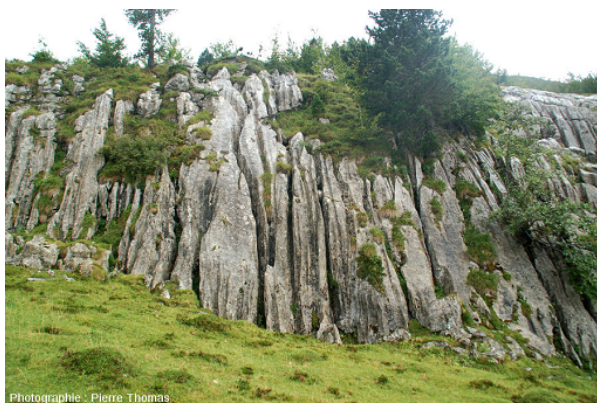
Figure 8. Exemple de karst, zone calcaire où les eaux de ruissellement chargées de \text{CO}_2 ( \text{CO}_2 atmosphérique et surtout \text{CO}_2 du sol produit par la respiration des racines, des champignons ...) conduisent à la dissolution du calcaire. Photo Pierre Thomas
