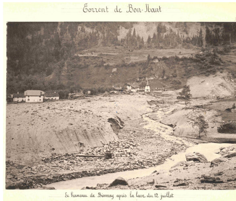
Figure 4 : Hameau de Bionnay ravagé par la rupture de la poche du glacier de Tête Rousse et la lave torrentielle qui s'est formé en aval. Catastrophe qui engendra 175 morts en 1892 (source Kuss [19])
