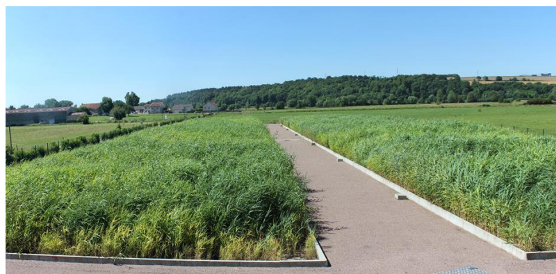
Figure 11. Filtre planté de roseaux. [Source : Photographie fournie par la société Jean Voisin du groupe Opure. Photos transmises par Joelle Paing.]
