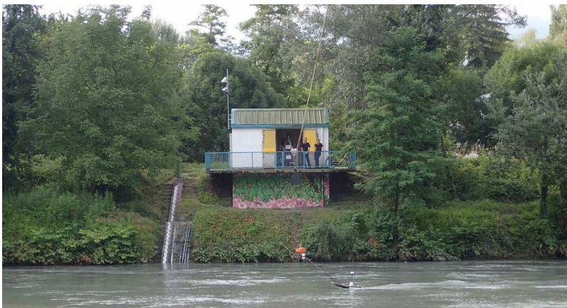
Figure 2. Station de mesure des débits de l'Isère à Grenoble sur le campus universitaire de Gières Saint-Martin d'Hères [Source : crédit photo LTHE (Laboratoire d'Etude des Transferts en Hydrologie et Environnement, maintenant Institut des Géosciences de l'Environnement, IGE, Grenoble)]
