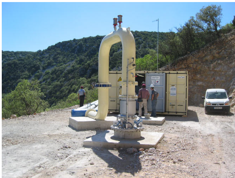
Figure 11. Test de pompage à fort débit, source des Cent-Fonts (Hérault). [Source : Photo M. Bakalowicz]
