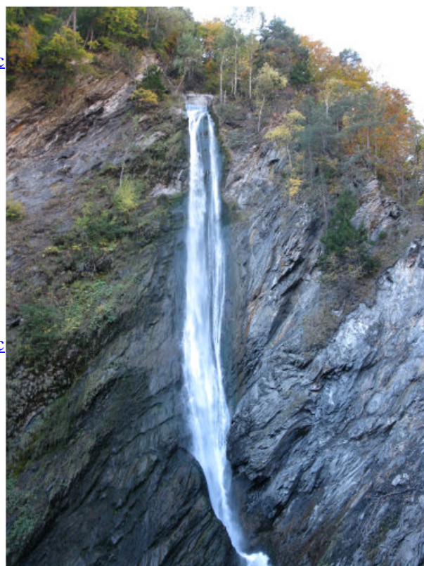
Figure 7 : Débouché aval du tunnel de contournement du glissement de terrain sur le torrent du Morel (Aigueblanche, 73). Le tunnel, percé dans le versant stable situé en face du glissement de terrain, détourne le torrent du pied du glissement (situé de l'autre côté du vallon qu'on devine sur la droite de la photo) et empêche le cours d'eau d'éroder le pied de la masse instable et de se charger de sédiments qu'il transporterait en aval sur les zones à enjeux (© Guillaume PITON)
