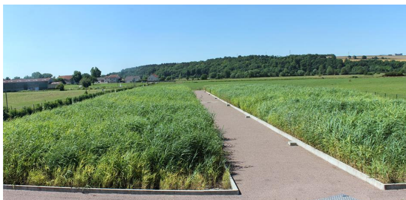
Figure 11. Filtre planté de roseaux. [Source : Photographie fournie par la société Jean Voisin du groupe Opure. Photos transmises par Joelle Paing.]
