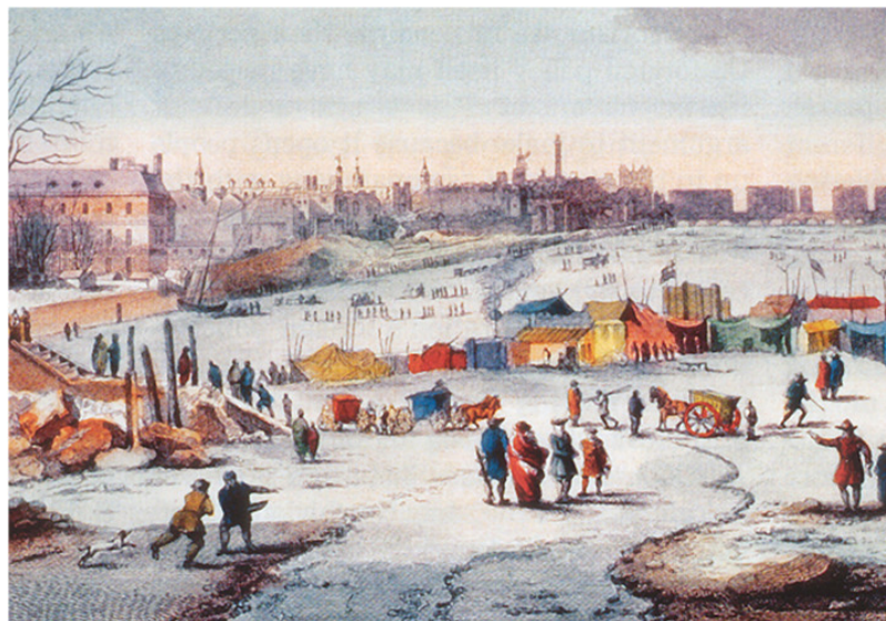
Figure 5. Fête sur la Tamise englacée près des escaliers du Temple en 1683-84 de Thomas Wyke. [Domaine public].
