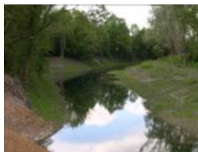
Figure 10. Lône de Malourdie (Chute de Chautagne) après travaux de restauration [Source : © Camille Moirenc]
