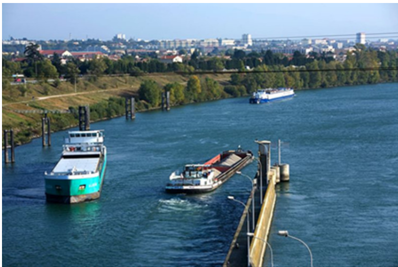
Figure 5. Entrée d'écluse [Source : ©Camille Moirenc]
