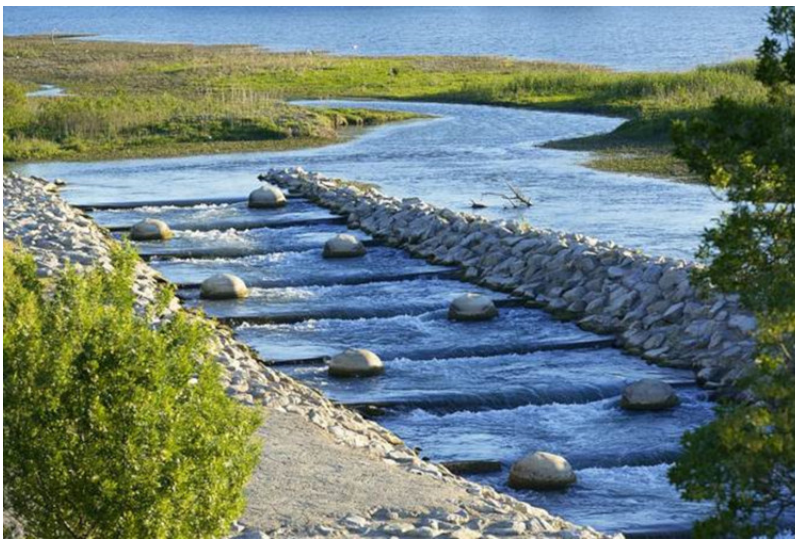
Figure 9. Passe à poissons au seuil de Comps (Gardon) [Source : ©Camille Moirenc]
