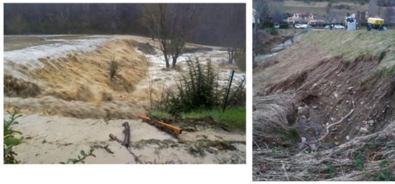
Figure 1. Surverse du barrage de Chalabre (département de l'Aude, janvier 2020) et niche d'érosion résultante [photos P. Gastineau et A. Wautier].
