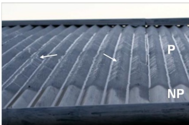
Figure 4. Gouttes glissant sur un toit en fer galvanisé ondulé à Combarbala (Chili) avec un petit angle d'inclinaison ( \approx 15^\circ ). P : Partie peinte avec des additifs (OPUR [12] ) où la rosée se forme et les gouttes glissent sur les ondulations (flèches). NP : Partie non peinte où la rosée ne se forme pas. [Source : J.-G. Minonzio].
