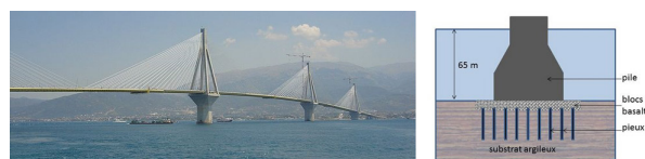
Figure 7. Le viaduc à haubans de Rion-Antirion, en béton armé et acier, mis en service en 2004, traverse le détroit de Patras en Grèce, très sismique, par 65 m d'eau, dont le fond marin est constitué d'une épaisse couche principalement argileuse et molle. Long de 2883 m, reposant sur 4 piles d'un diamètre de 90 m et d'une portée maxima entre piles de 560 m, il cumule les mesures préventives. L'argile située sous les piles est renforcée par une forêt de pieux métalliques, de 30 m de long, ce qui interdit une rotation d'ensemble sol-pile. Ces pieux sont surmontés par une couche granulaire fusible (blocs de basalte), permettant un déplacement relatif horizontal (glissement irréversible) pieux/piles lors des séismes importants. A gauche vue du viaduc. A droite principe d'amélioration du sol de fondation. [source : Gauche, By David Monniaux (Own work) [GFDL ( http://www.gnu.org/copyleft/fdl.html ), CC-BY-SA-3.0 ( http://creativecommons.org/licenses/by-sa/3.0/ ) or CC BY-SA 2.0 fr ( http://creativecommons.org/licenses/by-sa/2.0/fr/deed.en )], via Wikimedia Commons. Droite, Marc Boulon]
