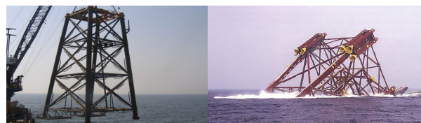
Figure 2. A gauche, un des éléments de jackets support d'une plateforme off-shore, jusqu'à 300 m d'eau, taille et poids comparable à ceux de la Tour Eiffel. A droite, jacket muni de caissons de flottaison, en cours de remorquage sur site ; fourreaux de guidage des pieux (diamètre 2 m, longueur 50 à 100 m) de clouage sur le fond marin sableux. [source : A. Puech, 2008, Cours de géotechnique marine, ENSHMG ]
