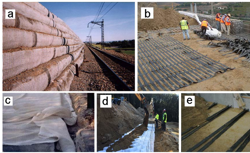
Figure 2. Renforcement des massifs de soutènement. (a) Mur renforcé par géosynthétiques ; (b) renforcement par géogrilles ; (c) Renforcement par nappes géotextiles ; (d) Renforcement par structures alvéolaires (procédé Armater [1]) et (e) renforcement par bandes géotextiles.
