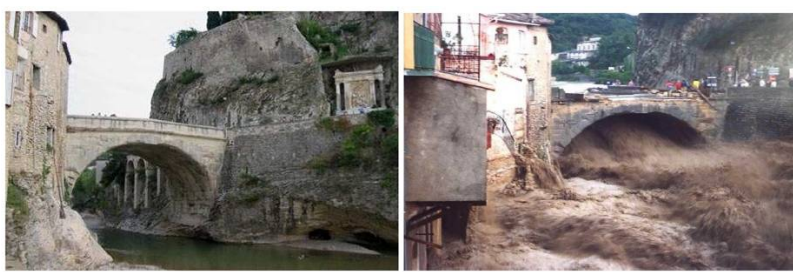
Figure 1. L'Ouvèze à Vaison la Romaine ; le débit de cette rivière de Provence a pu passer de 0,1 \text{ m}^3/\text{s} —photo de gauche, été 1990— à près de 1200 \text{ m}^3/\text{s} —photo de droite, 22 Septembre 1992— ceci pour un débit moyen annuel proche de 6 \text{ m}^3/\text{s} [Source : crédit EDF DTG]
