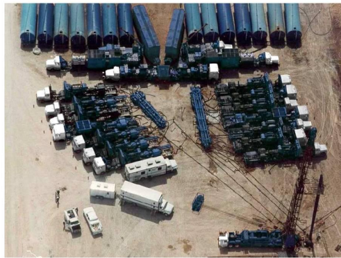
图 3.非常规油气开采的水力压裂作业。底部有可供注入约 500 立方米的水箱。在右下角的图中可以看到钻头。储罐前面的卡车提供流体-砂混合物的准备，流体-砂混合物由两排卡车安装的泵注入。每台泵的功率约为 500 马力。[来源：斯伦贝谢的照片]
