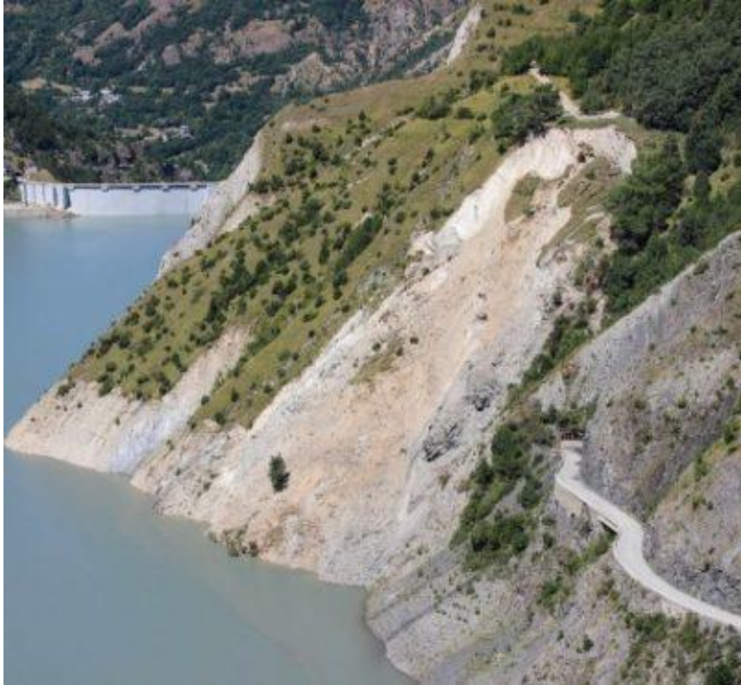
图 14. 尚邦坝湖（法国伊泽尔省）上方的滑坡。该滑坡自 2015 年 4 月以来一直处于活动状态，涉及 80 万立方米的易碎页岩 [图片来源：转载自《滑坡》，EEnv]。
